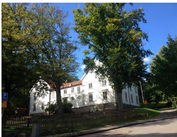
Skogshyddan, fasaden är klädd med ljusgrå locklistpanel med omsorgsfullt utförda snickerier.
